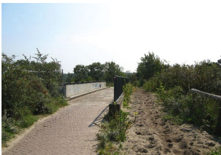
HET ECODUCT, VERDEELT IN EEN VERHARD PAD VOOR FIETSER EN WANDELAAR, EN EEN ZANDPAD VOOR RUITERS
